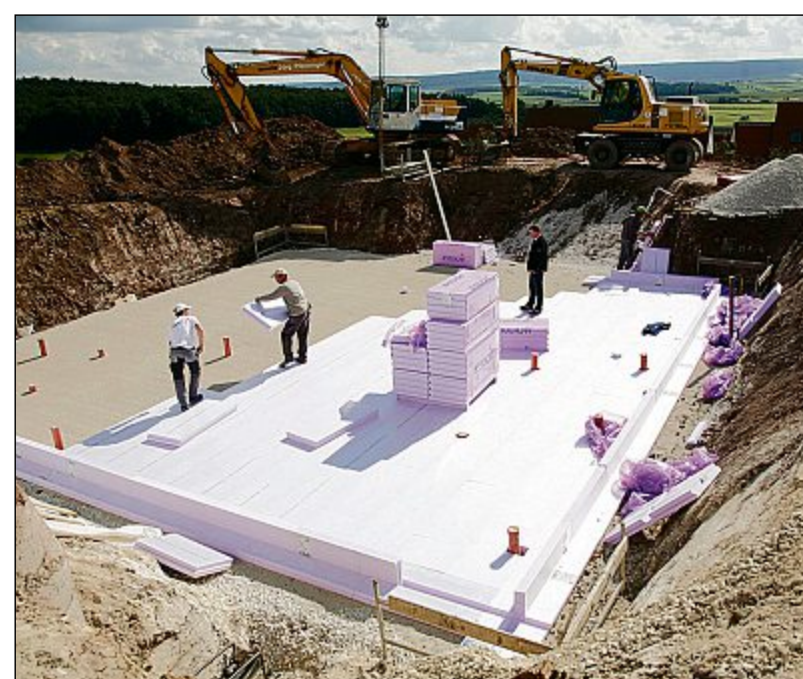
Durch die aufeinander abgestimmten Elemente geht die Verlegung des zum Patent angemeldeten Stecksystems, das Dämmung und Schalung in einem ist, rasch voran.
