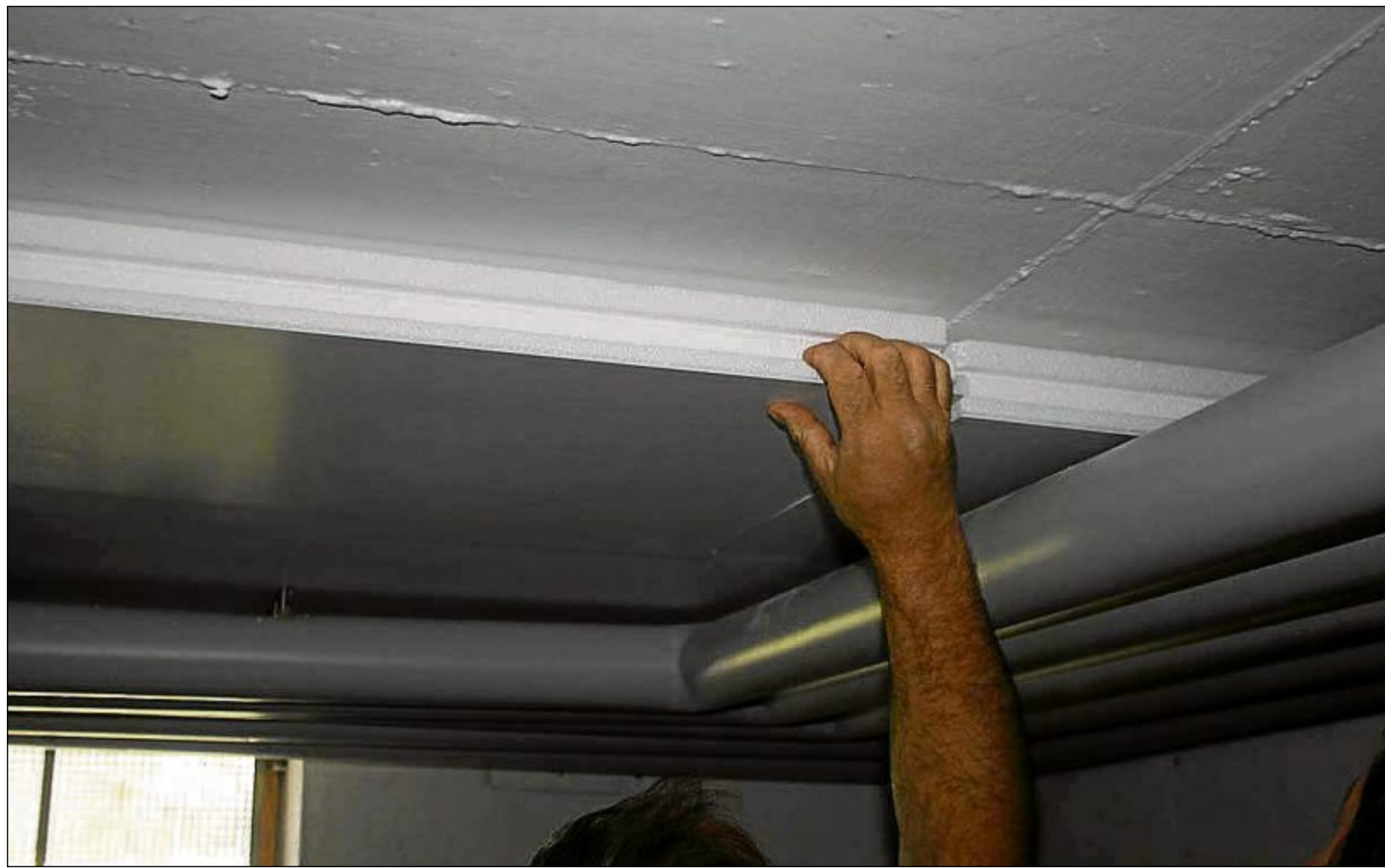
Eine Kellerdeckendämmung mit Styroporplatten.
